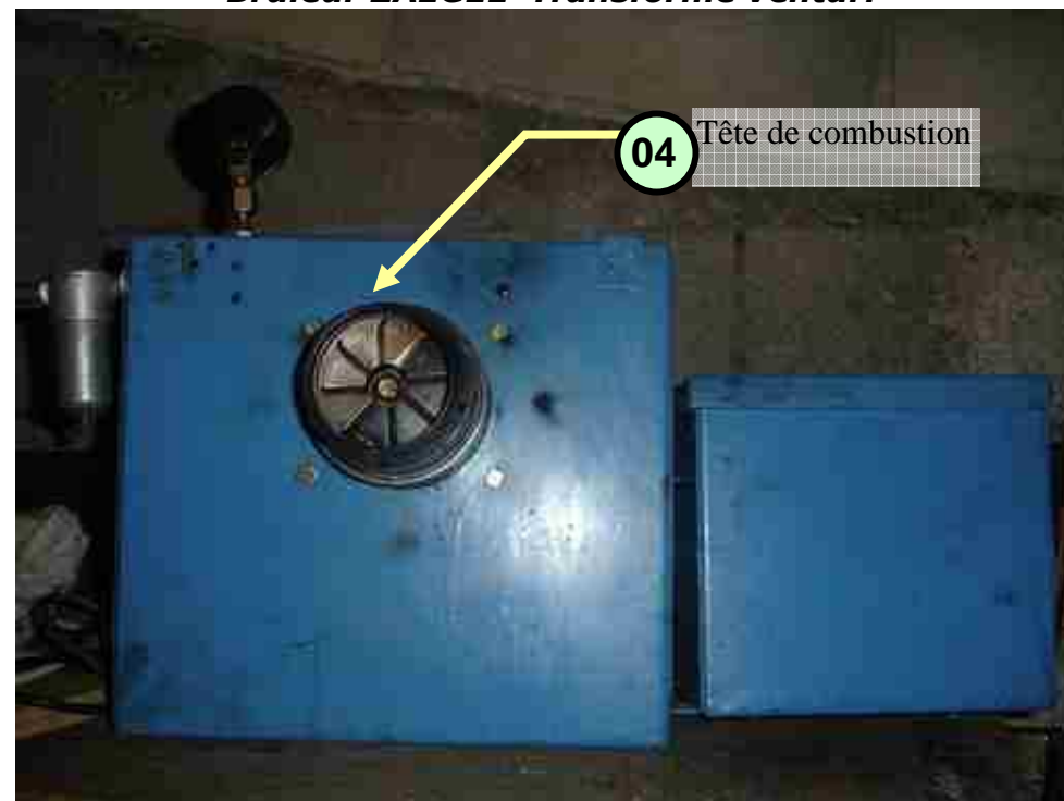
Brûleur ZAEGEL Transformé venturi
